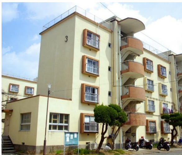
▲建替前の石橋西団地
