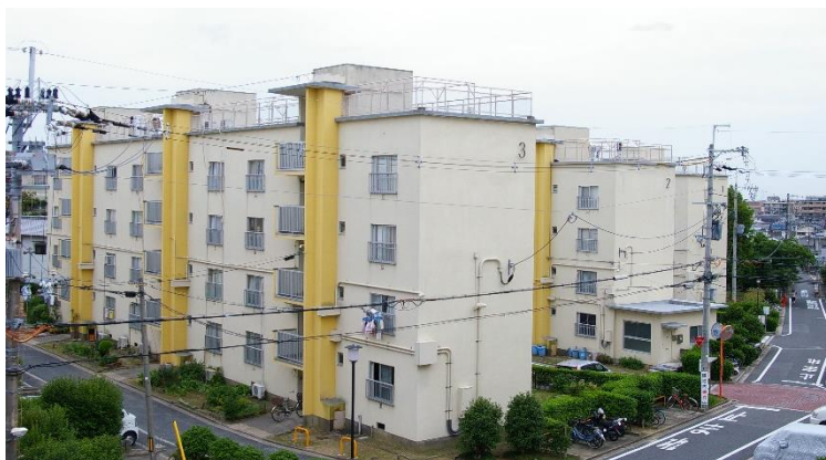
◁井口堂団地外観(現況)
