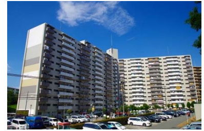
千里山田西団地 外観
