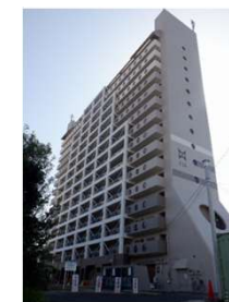
槇塚台団地（令和2年度耐震改修後）
