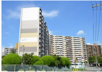
千里山田西団地（令和4年度耐震改修実施）
