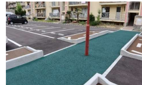
喜連団地 リニューアル後の駐車場
