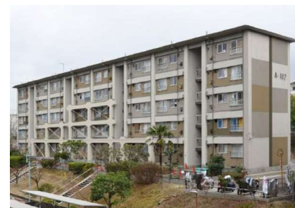
香里三井C団地（平成26年度耐震改修後）
