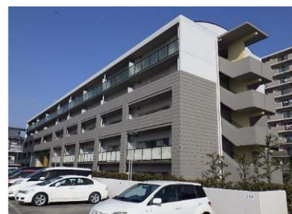
豊中B団地 リニューアル後の外壁
