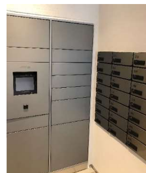
宅配ボックス
