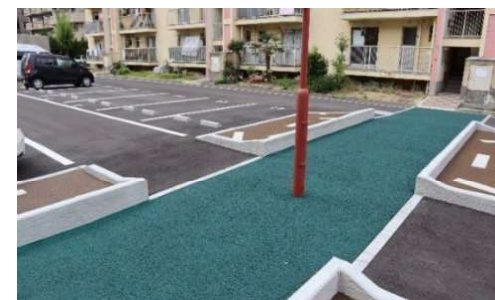
喜連団地 リニューアル後の駐車場
