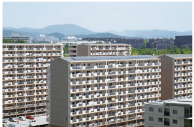
OPH北千里駅前(2011年) (屋根貸しによるソーラーパネルの設置)
