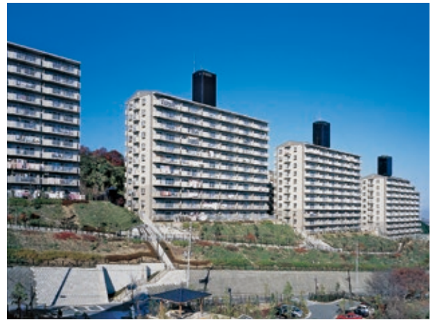
ロジエ長野（1991年）
