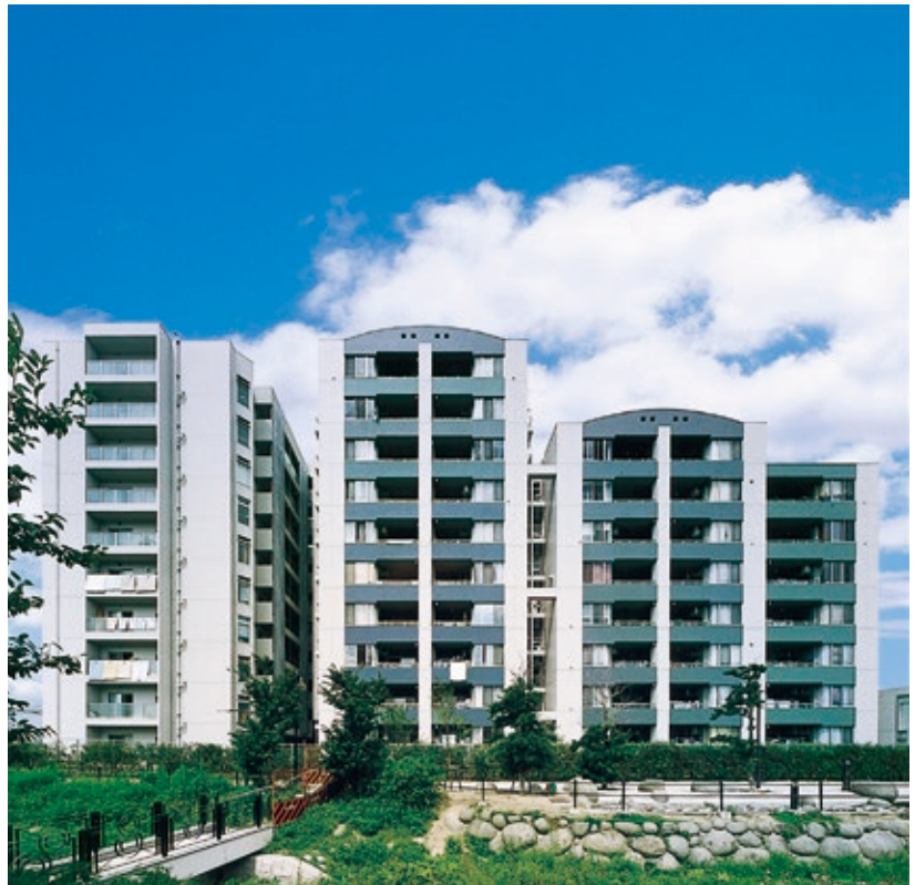
エルフラッツ萱島(2001年)
