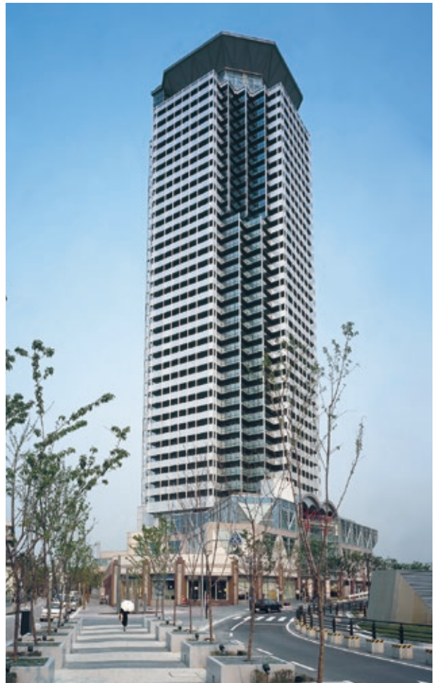
JR吹田駅北口地区・メロード吹田(1996年)
