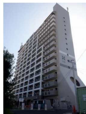
工法の一例（槇塚台団地）
