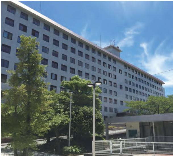
千里南町メゾネット住宅(1971年)
