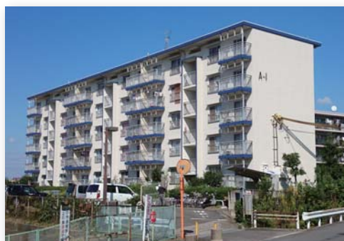
招提C 施工後
