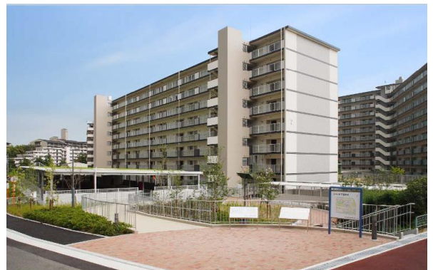
▲ 建替事業により建設された団地(OPH新千里南町)
