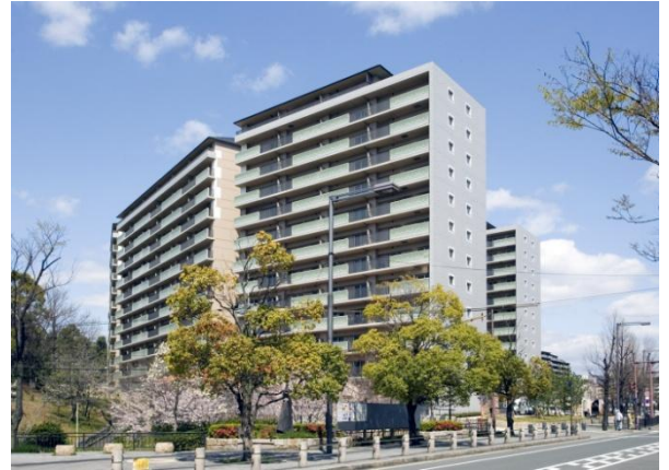
▲ 建替事業により建設された団地(OPH新千里西町)
