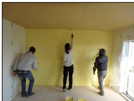
《壁にペンキを塗る作業》
