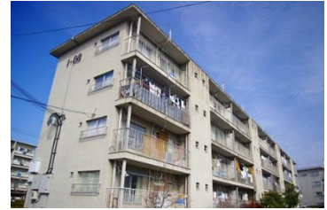
△金岡東・金岡東 B 団地 (現況)
