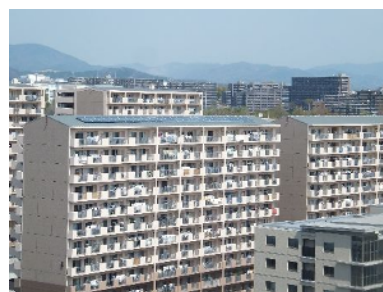
OPH北千里駅前（4号棟） ソーラーパネルの設置
