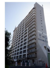
槇塚台団地（令和2年度耐震改修実施）
