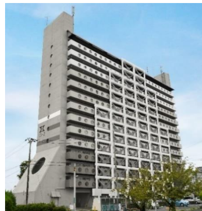
槇塚台団地（堺市南区） 外壁改修と耐震改修後の外観イメージ
