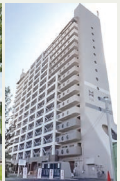
槇塚台団地 (令和2年度耐震改修実施)
