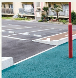
喜連団地 リニューアル後の駐車場
