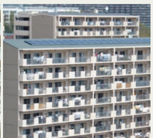
OPH北千里駅前(4号棟) ソーラーパネルの設置
