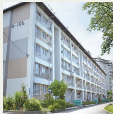
香里三井C団地 (平成26年度耐震改修実施)
