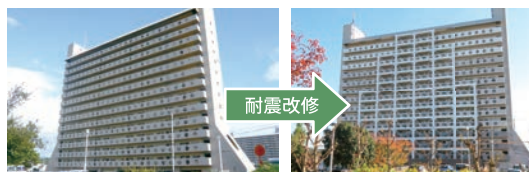
耐震改修前(晴美台D団地)
