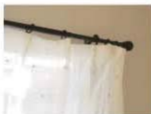
カーテンレールの取替
