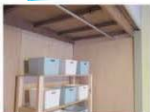
ハンガーパイプの取付
