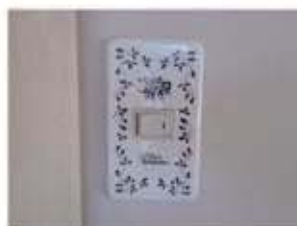
スイッチプレートの取替
