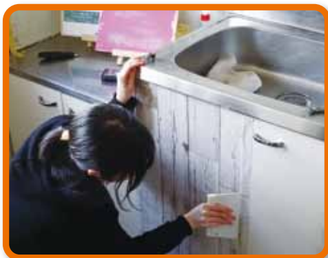
キッチンシート貼り
